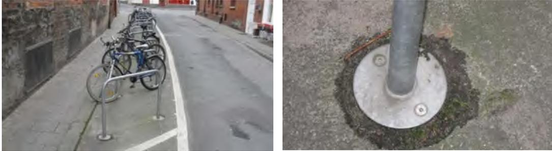
Abb. 8-2: Beispiele für verschraubte Rahmenhalter (Lüneburg)
