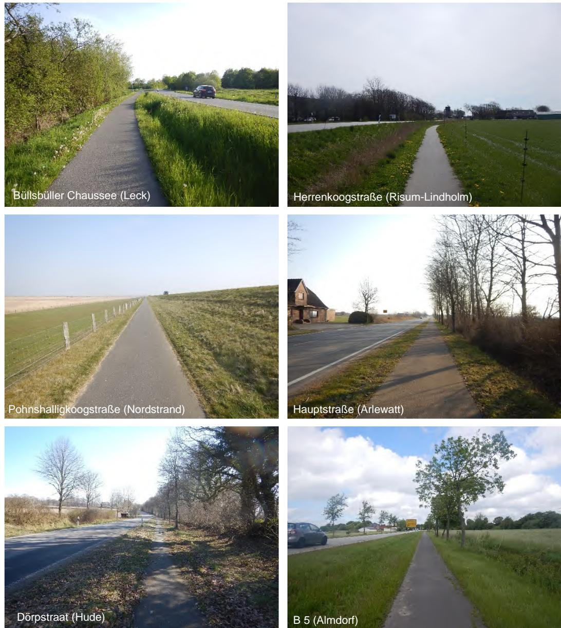
Abb. 7-7: Beispiele für bestehende straßenbegleitende Radverkehrsanlage mit Ausbaubedanken aufgrund zu geringer Wegebreiten
